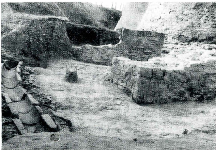
Fig. 1. Cetatea de Scaun a Sucevei. Baza picioarelor podului și o porțiune din jgheabul de scurgere a apei.
